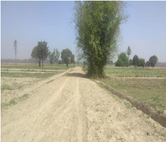
डाँडा बिचवा ढुकरी कुइया मार्ग सडक ट्रयाक निर्माण स्तरोन्नती वडा नं. १
